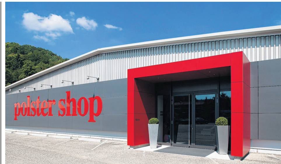
1400 Quadratmeter umfasst die Verkaufsfläche des Polster Shops Nagold.
